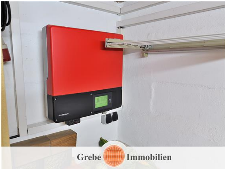
Photovoltaik Wechselrichter
